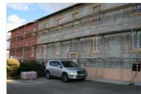
Façade en rénovation
