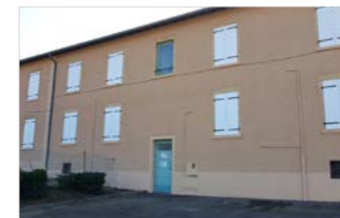
Façade et volet rénové
