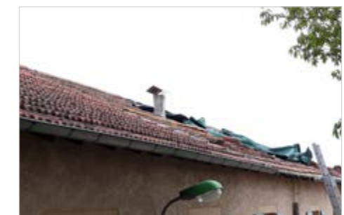
Réfection de la toiture
